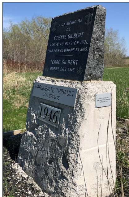
Monument avant la restauration
