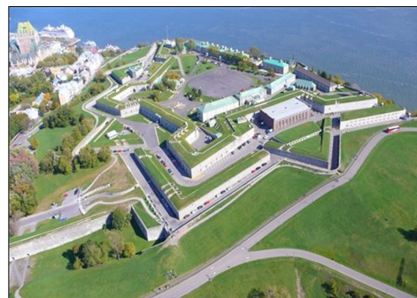
Vue aérienne de la Citadelle
