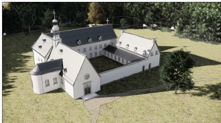
Hôpital Général de Québec
